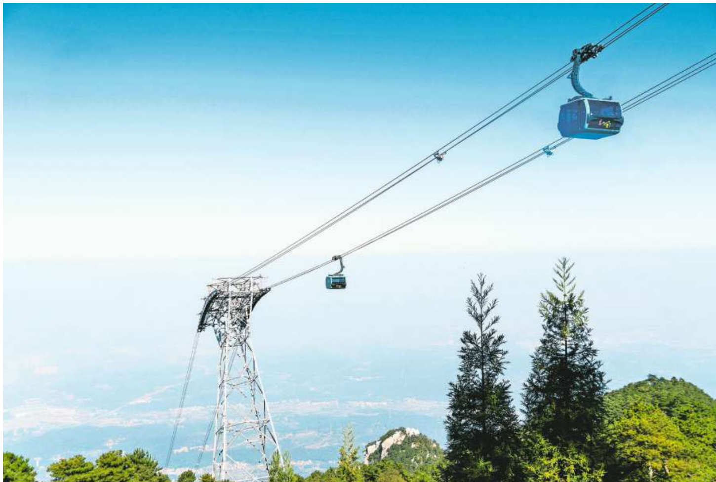
Doppelmayr/Garaventa baute die erste Dreiseilbahn Chinas von Jiujiang auf den Berg Lushan. Kapazität: 3000 Personen pro Stunde. Bild: PD
