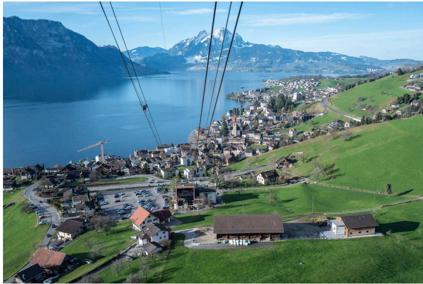
Die Gemeinde Weggis aus Sicht der Rigi-Pendelbahn.
