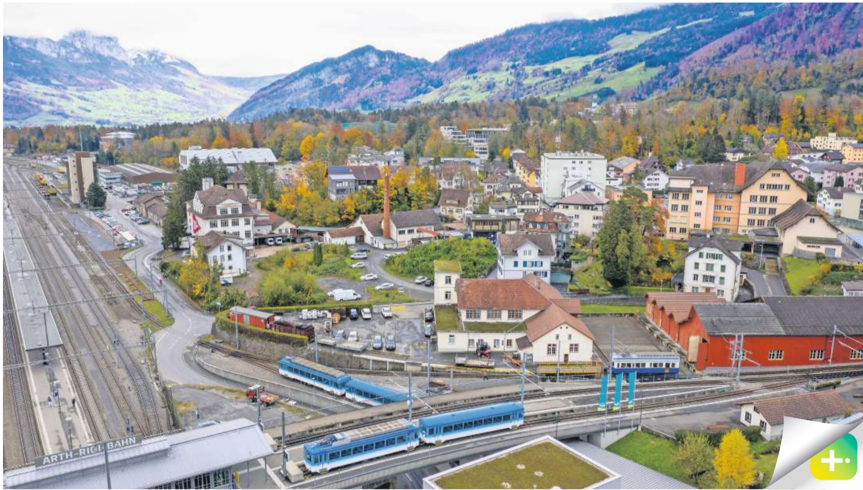
Mit dem Rigibahndepot (vorne rechts), der Luxram (mit Hopp-Schwyz-Fahne, rechts an der Bahnlinie) und der direkt anschliessenden Milchküche und einer Villa sollen vier markante Gebäudekomplexe abgebrochen werden. Gegen die entsprechende Nutzungsplanung sind Einsprachen eingegangen. Bild: Erhard Gick
