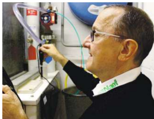
Umfassende Zustandsanalyse vor Ort.
