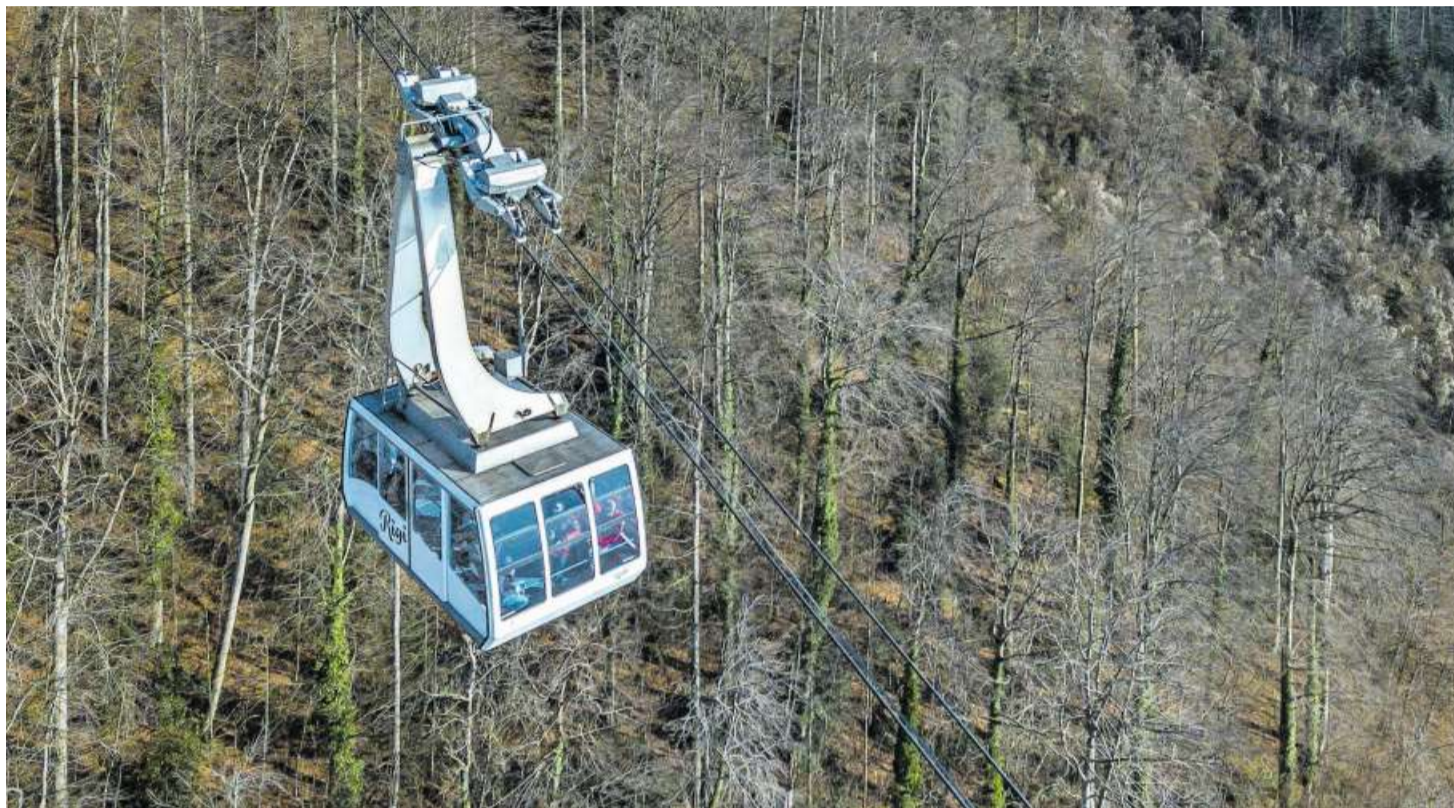
Führt zu grossen Teilen über Waldgebiet: die Luftseilbahn Weggis–Rigi Kaltbad.
